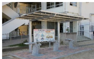
校舎側に設けられたミストシャワー付給水場
